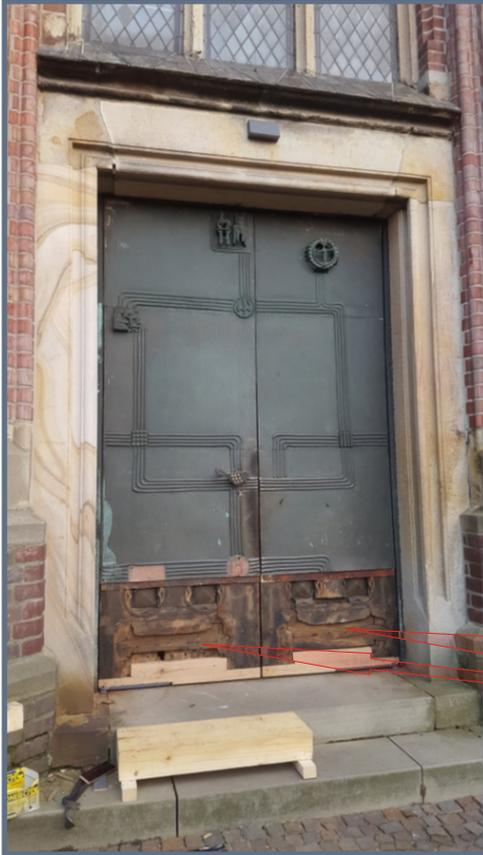
Am Abend des zweiten Tages konnten beide Türen wieder eingehangen werden. Lager und obere Lagersitze wurden gefettet und unten mit einer Hülse ergänzt. Stahlteile zweimal mit Korrosionsschutzfarbe lackiert.
