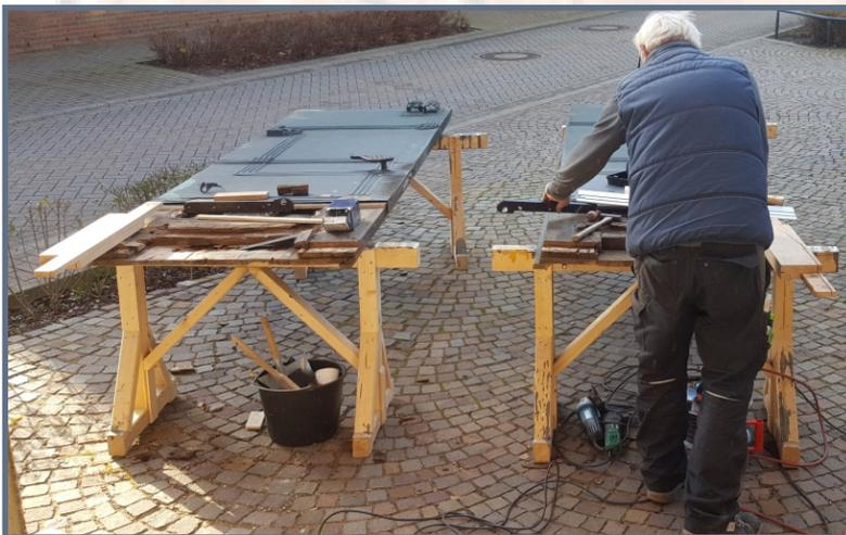
Einpassen der vorbereiteten Holzbauteile an beiden ausgehangenen Türen. Beide Sockelholzer wurden auf den Böcken befestigt.
